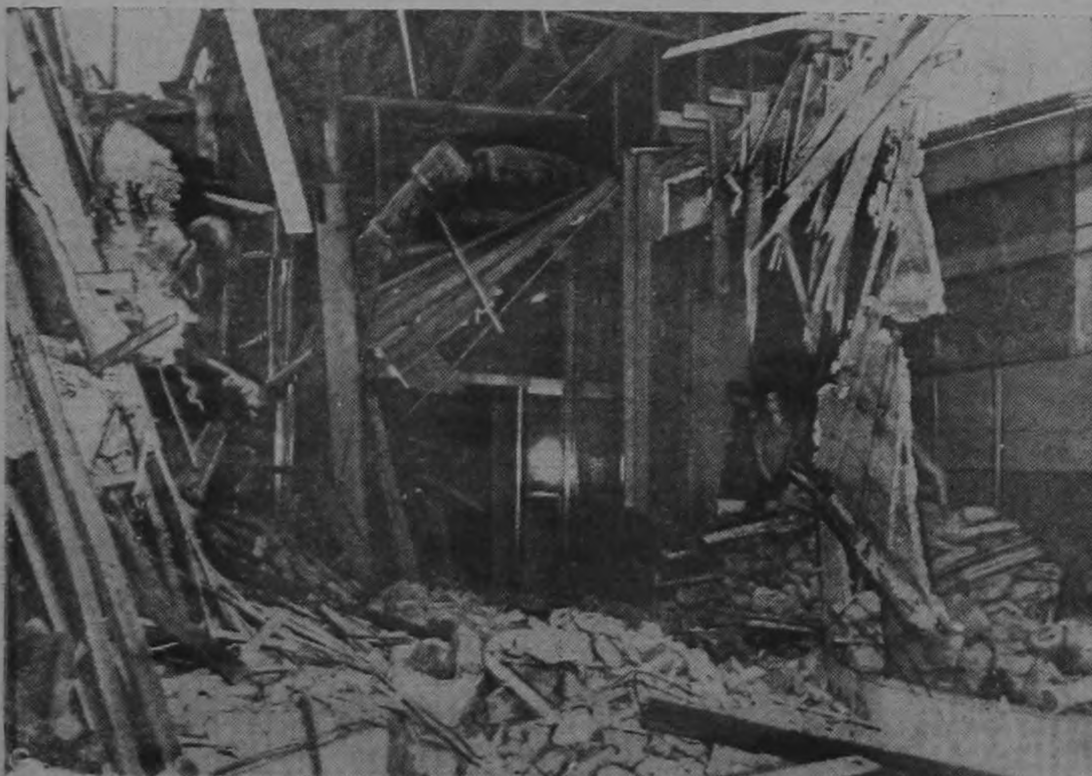
La magnitud e intensidad de los fuertes temblores producidos recientemente en Bakersfield, California, se aprecian fácilmente en los destrozos causados en este almacén. La Cruz Roja informó "cuatro muertos confirmados".
